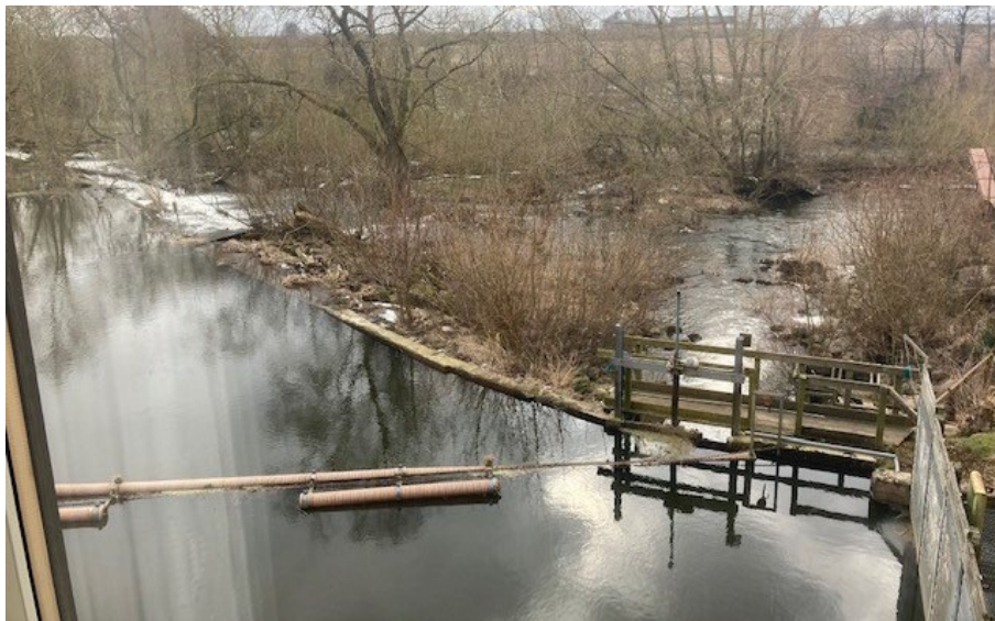
Figur 11. Foto av dämnet taget från kontorsbyggnad på den norra stranden. I förgrunden till höger syns planluckan framför turbinintaget och till vänster om det syns planluckan framför rensutskovet intill vilken det finns en äldre fiskväg i trä.
