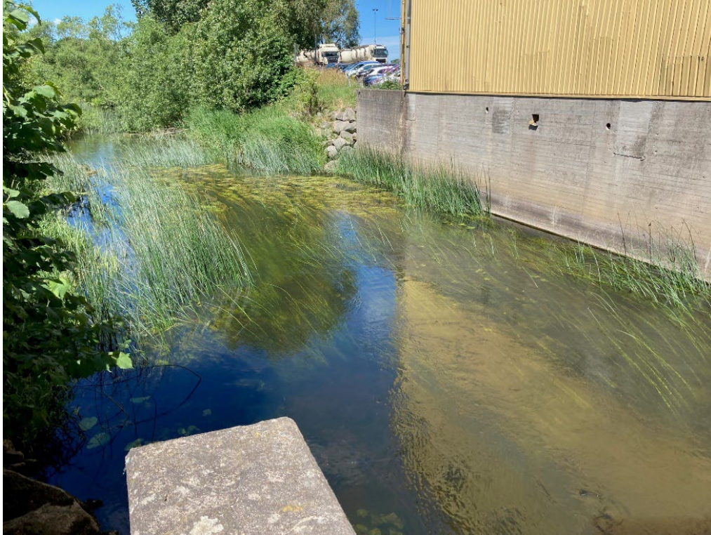
Figur 13. Uppströmsdel av utloppskanalen. Fotot är taget i riktning nedströms.
